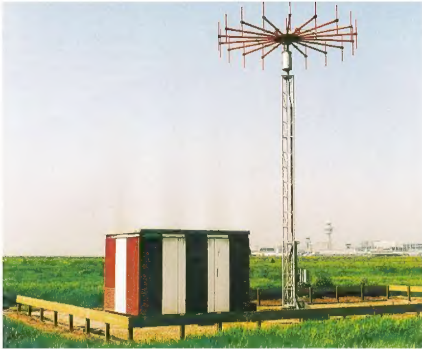
Radiopeiler. Er staan er zes in Nederland plus plaatselijke, zoals deze bij Schiphol.
